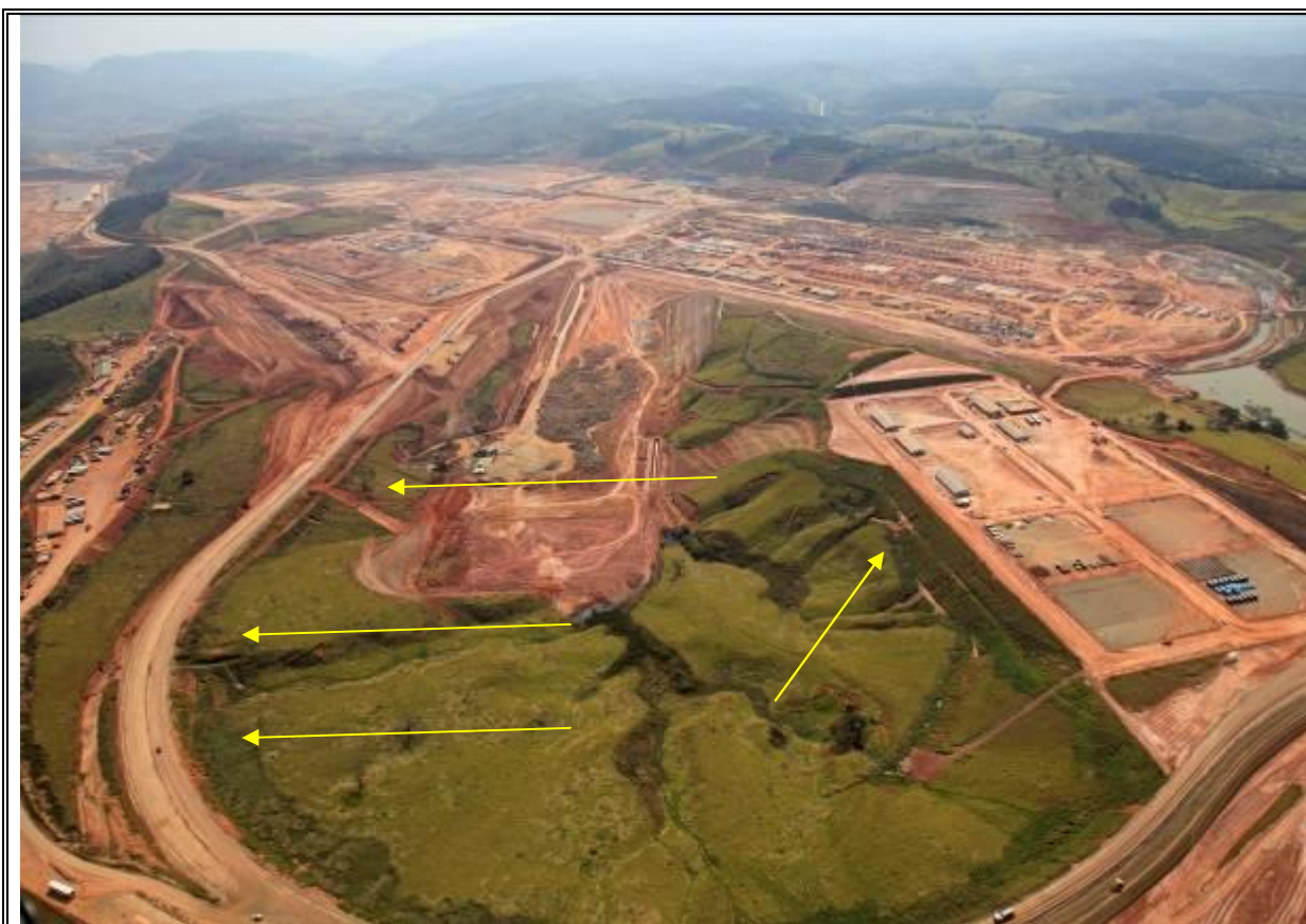
VISTA AEREA MOSTRANDO O SITE EM 2009. AS SETAS INDICAM PROBLEMAS NOS TALUDES ANTES DA PAVIMENTAÇÃO DA VIA.
