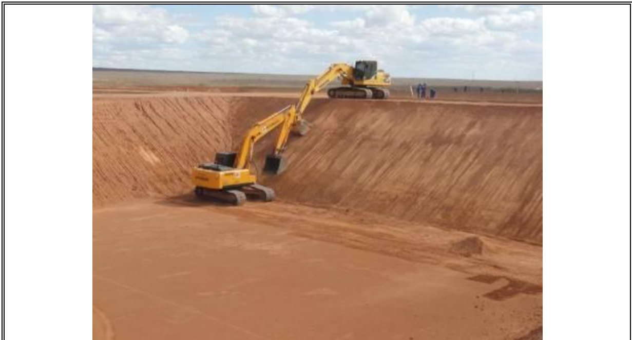
FOTO Nº 02 RETROESCAVADEIRAS REMOVENDO O MATERIAL SOLTO NAS EXTREMIDADE DE ATERRO DEVIDO A COMPACTAÇÃO INSUFICIENTE NESTAS ÁREAS.
