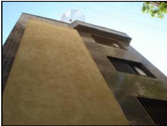
FOTO Nº. 19 – VISTA DA FACHADA DE FUNDOS DO PRÉDIO EM LÍTIGIO. NOTAR INEXISTÊNCIA DE DESPLACAMENTO.
